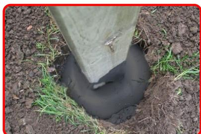
**Система HILST** была разработана для быстрой, даже моментальной засыпки лунок для столбов. Система HILST образует прочное основание, что позволяет производить монтаж заборной секции уже через 2 часа после заливки (для низких температур следует подождать 4 часа). HILST применим со столбами любого типа и с почвой любого типа, включая каменистую. Формула объема на странице 10 поможет определить количество материала, требуемое для заполнения лунки, в зависимости от ее глубины и диаметра.
